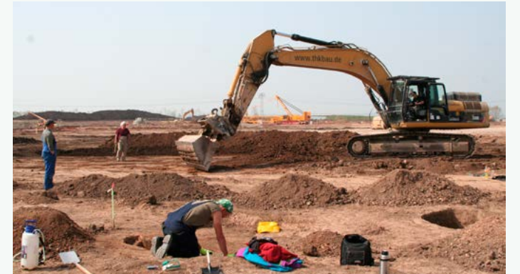
BUZ: Vor den Baufirmen rücken die Archäologen an. Grabungen im Stotternheimer ILZ. Foto: TLDA
